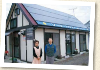
事務所の屋根にも、太陽光パネルがあります。
