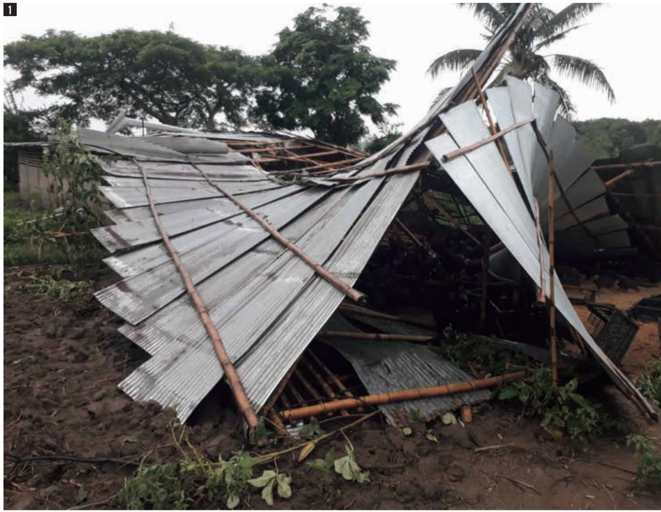
1 2024年9月にミャンマーを襲った台風11号により被害を受けた鶏舎。多くの鶏が飛ばされてしまい、行方不明になりました。 2 支援金で購入したブロック。施設の修復に使用されます。 3 新しい鶏舎を建設中の様子。
